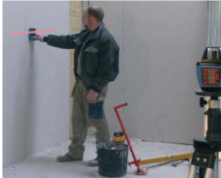
Obrázek 12 zachycení rotujícího paprsku přijímačem HS 14, skenování v daném prostoru - Mikrofyn ML 14i
