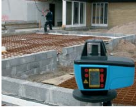
Obrázek 5 rotační laser Mikrofynd používaný při betonáži
