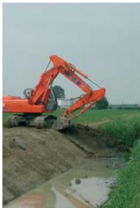
Obrázek 25 bagr při přesné skrývce zeminy v daném sklonu - systém MirkoDigger™
