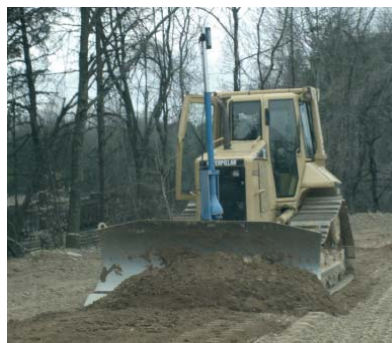
Obrázek 17 srovnávání vodorovné roviny buldozerem; příklad řízení stavebních strojů laserem - systém MikroDozer™ s rotačním laserem Mikrofyn ML 2, automatickým výsuvným stožářem EM 4 a přijímačem MD 10
